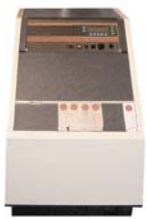
Alter Standard- heizkessel
